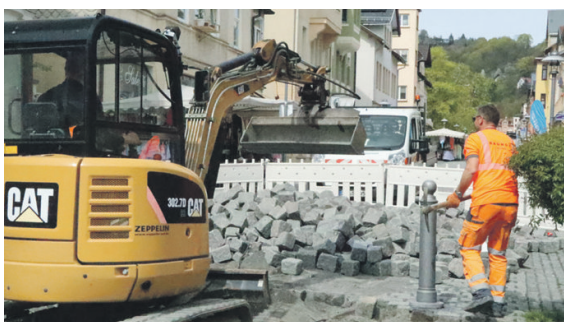
Mitarbeiter des Bauhofes Sonneberg bei Bauarbeiten in der Bahnhofstraße. Foto: Stadt Sonneberg/C. Heinkel
