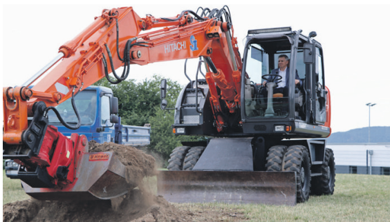
Mit dem Bagger setzte Bürgermeister Dr. Heiko Voigt den ersten „Spatenstich“. Foto: Stadt Sonneberg/C. Heinkel
