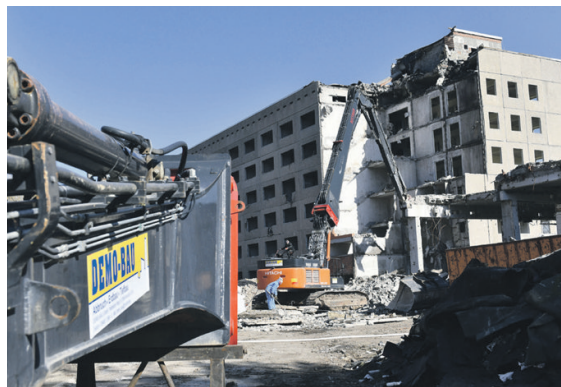
Das ehemalige Altersheim wird derzeit abgerissen. Foto: C.-H. Zitzmann
