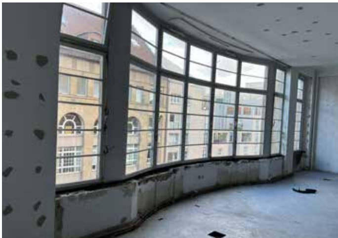
Die Fassade ist schon freigelegt, jetzt werden die historischen Fenster saniert
