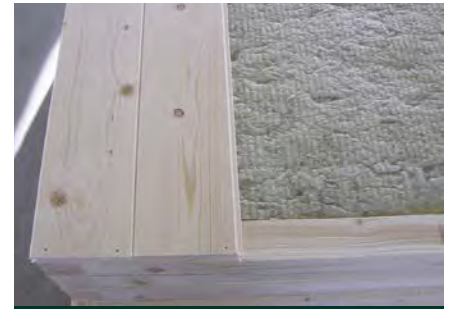
Gedämmte Zwischendecke im Saunaraum
