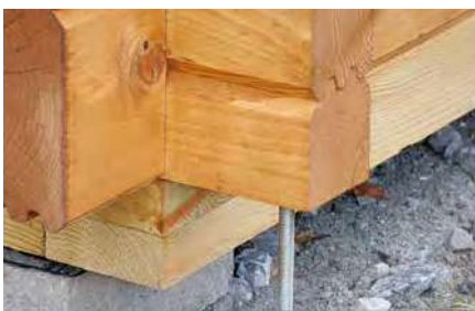
Gewindestangen ab Wandstärke 44 mm
