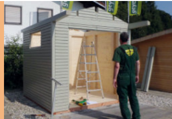
Einsetzen der fertig montierten Wand- und Giebelelemente
