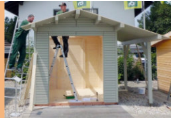
Erstellung der Dachschalung
