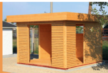
Dach- und Wandschalung
