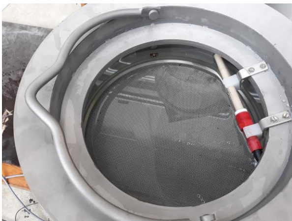
(a) Einbauvorrichtung der Leitfähigkeitssonde
