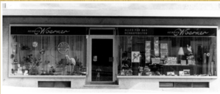
1963 Ladengeschäft in der Kramstraße nach dem Umbau
